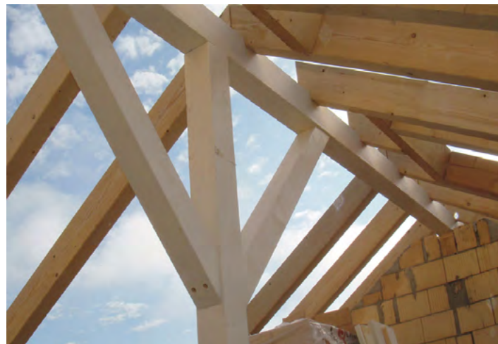
Holzkonstruktionen (Dachfenster, Lukarnen, Hallenbau)
