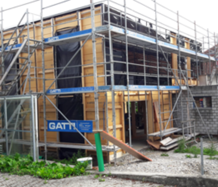
Schopf im Rohbau 202
