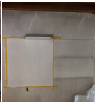
Bei den Reinigungs- und Sanierungsarbeiten wurde auch der Denkmalschutz hinzugezogen, damit alles im Originalzustand wiederhergestellt wird. Auf dem mittleren Bild sieht man den Materialtest des Malers, ob alles gut deckt und haftet.
