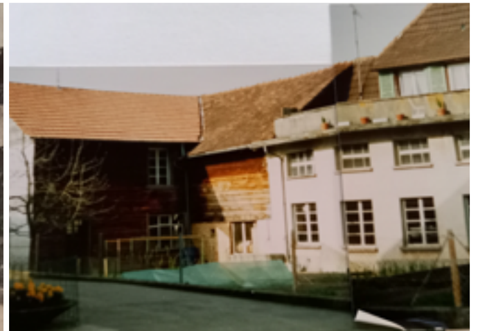
Schopf, angebaut 1959 an Haupthaus. Bild von 1989
