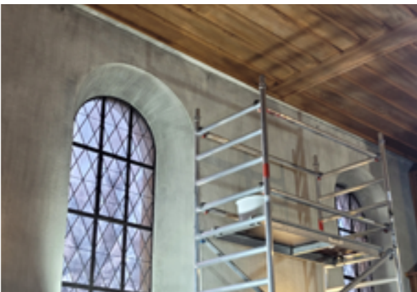
Bei den Reinigungs- und Sanierungsarbeiten wurde auch der Denkmalschutz hinzugezogen, damit alles im Originalzustand wiederhergestellt wird. Auf dem mittleren Bild sieht man den Materialtest des Malers, ob alles gut deckt und haftet.
