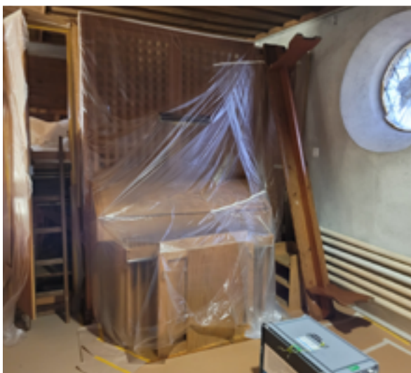
Teil für Teil wurde die Orgel auseinandergenommen, in Basel gereinigt und wieder zusammengesetzt. In der Mitte erhält man einen Eindruck des Zustands der Orgel nach dem Brand, auf dem rechten Bild liegen die bereits gereinigten Teile für den Wiedereinbau bereit.
