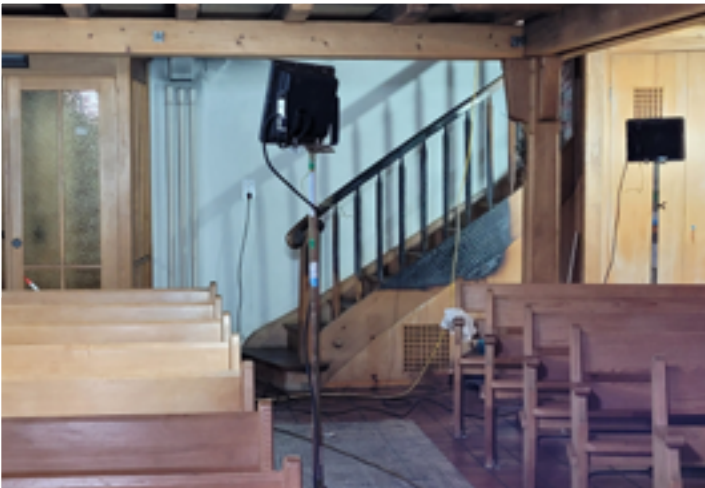
Die gesamte Treppenseite mit dem verkohlten Teil wird entnommen und das fehlende Stück originalgetreu nachgebaut und wieder eingesetzt. Die Russ-schicht konnte nur mit einer Spezialfirma entfernt werden. Links sieht man den Unterschied zwischen den gereinigten und ungereinigten Kirchenbänken.
