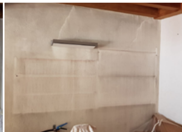
Bei den Reinigungs- und Sanierungsarbeiten wurde auch der Denkmalschutz hinzugezogen, damit alles im Originalzustand wiederhergestellt wird. Auf dem mittleren Bild sieht man den Materialtest des Malers, ob alles gut deckt und haftet.
